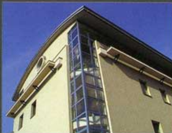
Административное здание в 5-м Монетчиковском переулке Москва, 5-й Монетчиковский пер., дом 3, стр. 1 Строительство – 1996 год Архитекторы: Сергей Киселев, Михаил Чирков
