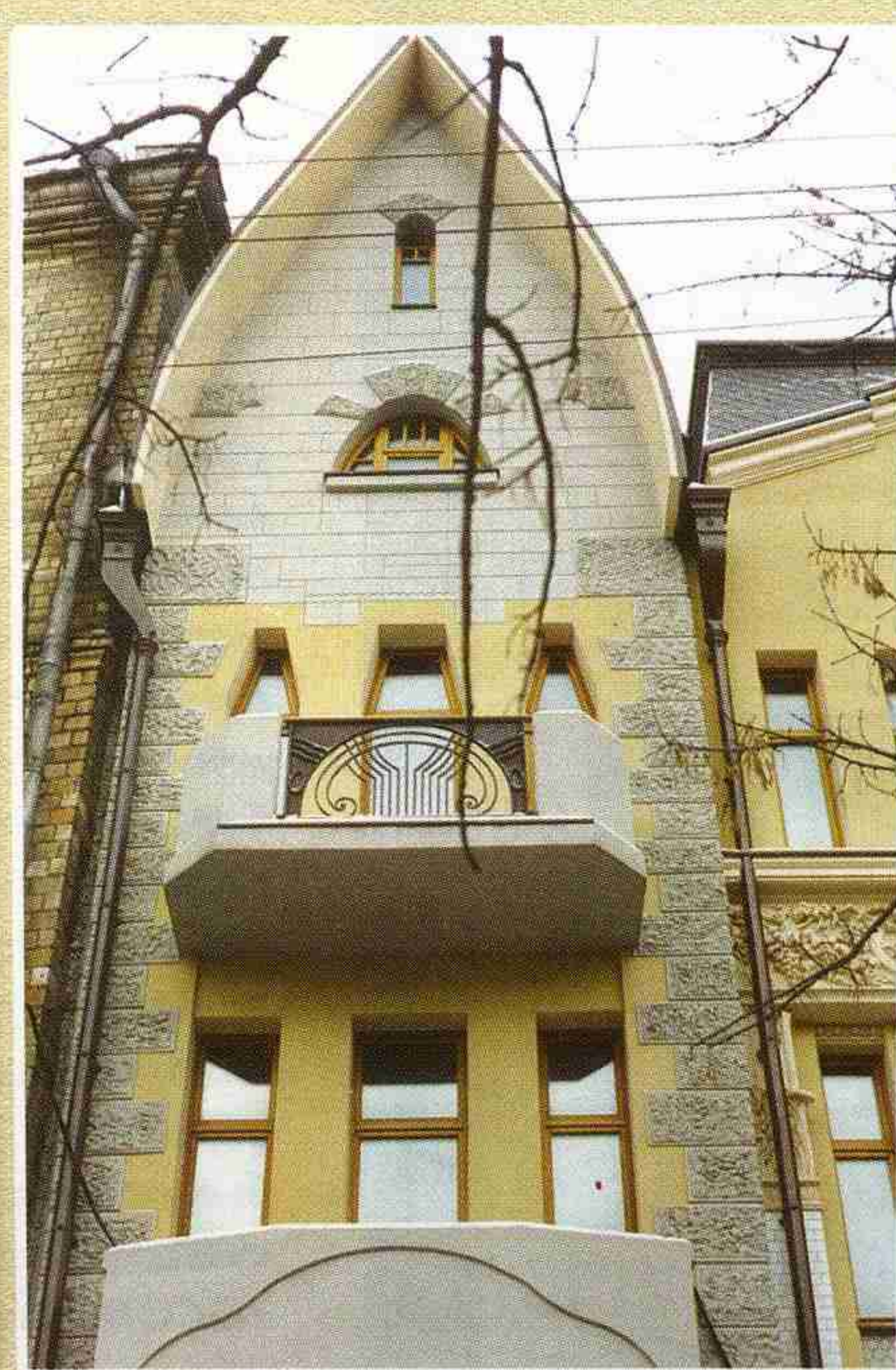
Реконструкция жилого дома в Чистом переулке. Архитекторы: С. Скуратов, М. Чирков, С. Киселев, архитектор-реставратор Н. Сафонцева; инженер И. Шварцман. Заказчик – жилищное товарищество «КСО». В этом проекте удалось, отреставрировав уличный фасад и главную лестницу, увеличить общую площадь здания с 1300 до 2375 м 2 , а количество используемых уровней – с 4-х до 7-ми. В подземном уровне размещен гараж на 7 автомобилей, а на первом этаже – общественный блок. Траектория дворовых фасадов современна и не повторяет исторические главные фасады
