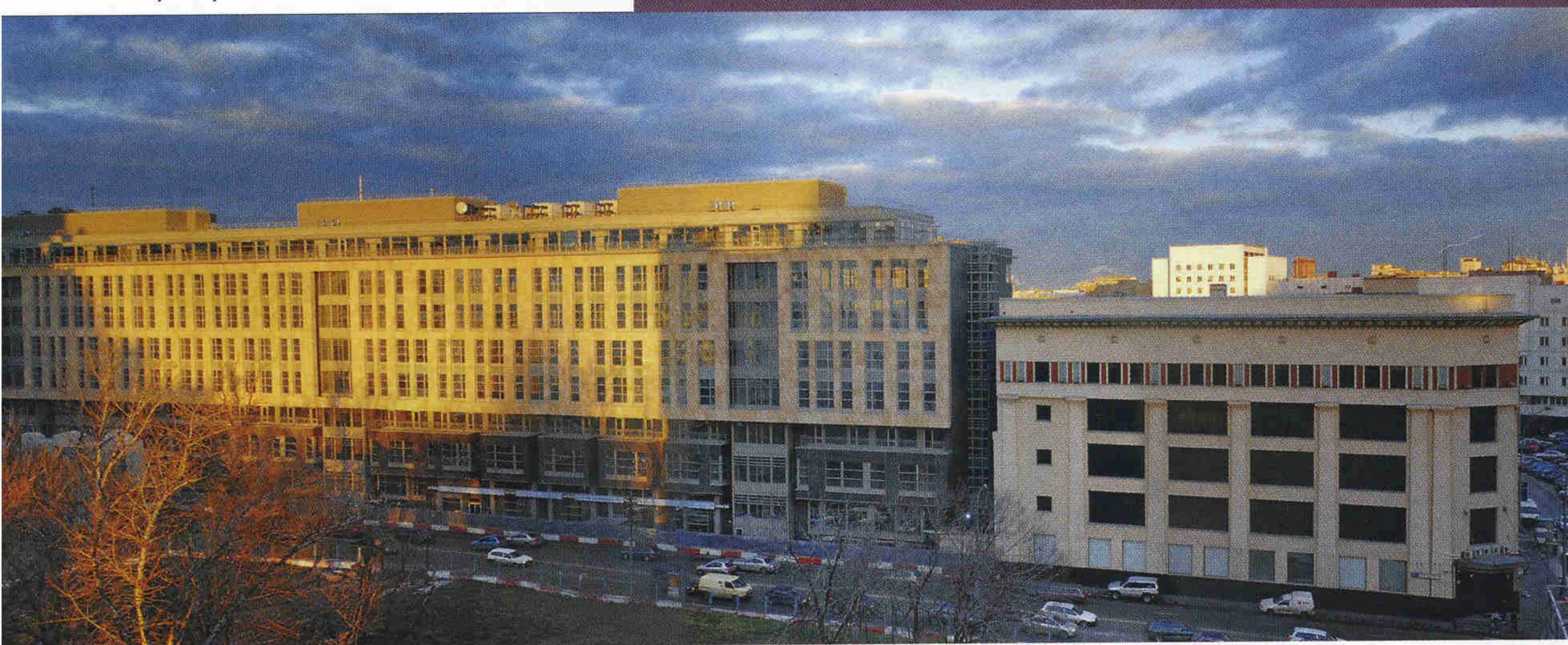
Деловой центр "Эрмитаж-плаза" на Краснопротарской улице в Москве Сергей Киселев построил в 2006 году на месте выведенного из центра города завода "Тизприбор". Здание общей площадью тридцать восемь тысяч квадратных метров состоит из двух корпусов: восьмизэтажного и четырехэтажного.
